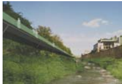
Der "Rad-Highway" nahe der U4-Station Ober St. Veit.
