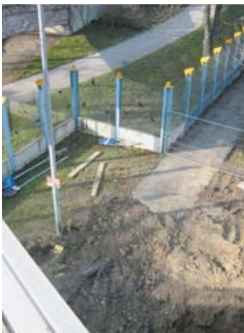
Seit November 2008 wird endlich am neuen Aufzug zum Hackinger Steg gebaut.
